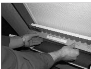
Obr. 42 Nasazení filtru.
