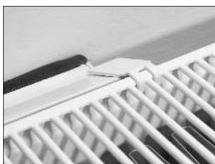
Obr. 46 Otopné těleso zajištěné proti neúmyslnému odklopení.
