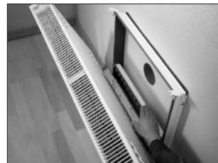
Obr. 19 Výměna filtru
