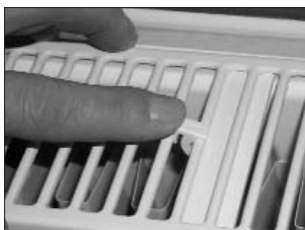
Obr. 44 Přichycení krycí mřížky.
