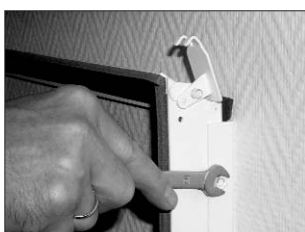
Obr. 39 Šrouby, s jejichž pomocí lze upravit vzdálenost rámu od zdi.
