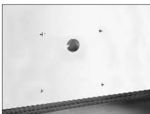
Obr. 35 Určení a označení upevňovacích bodů.
